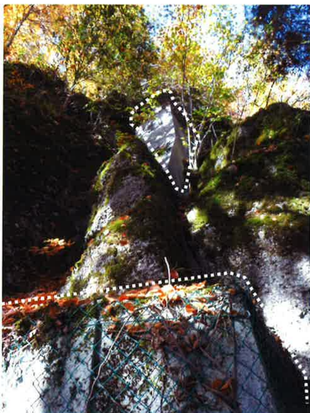
Photo 6 : Présence de sous-murages en béton à l'extrémité Sud de la zone d'étude.
