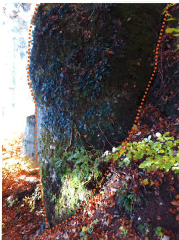
Photo 5 : Masse de stabilité précaire d'environ 40 m 3 , située au Sud des escaliers.
