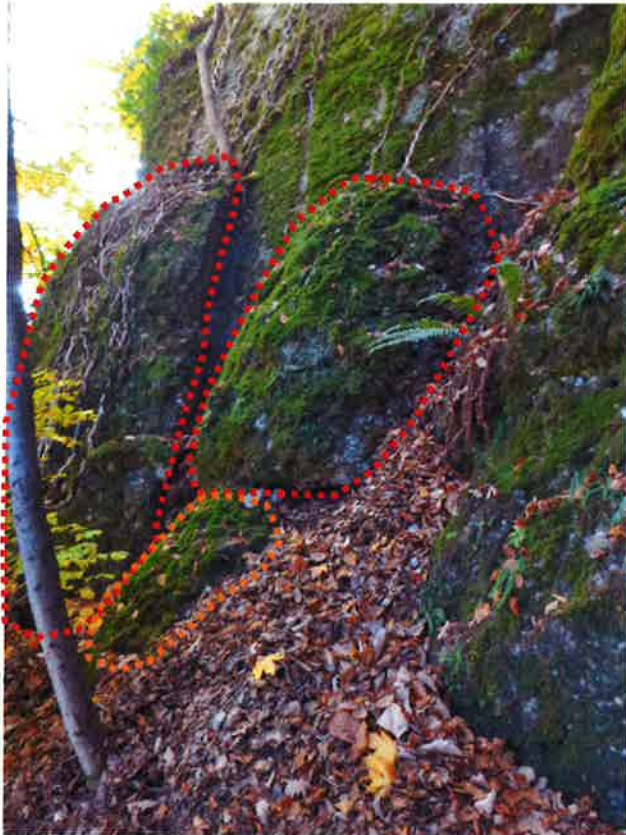
Photo 3 : Masses instables de 0.5 à 6 m 3 , situées au Nord du secteur.
