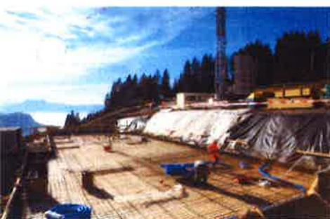
© Blonay - Chantier de l'Espace régional des Pléiades
